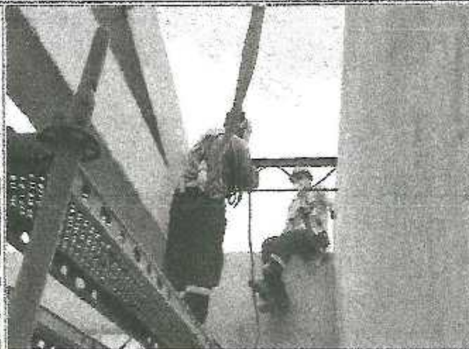
Vista; MONTAJE DE CORREAS METÁLICAS MÓDULO B
