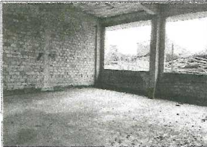
Vista; VACÉO DE CONCRETO EN FALSO PISO MÓDULO G
