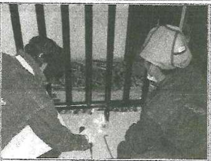
Vista; INSTALACIÓN Y FIJACIÓN DE BARANDAS METALICAS
