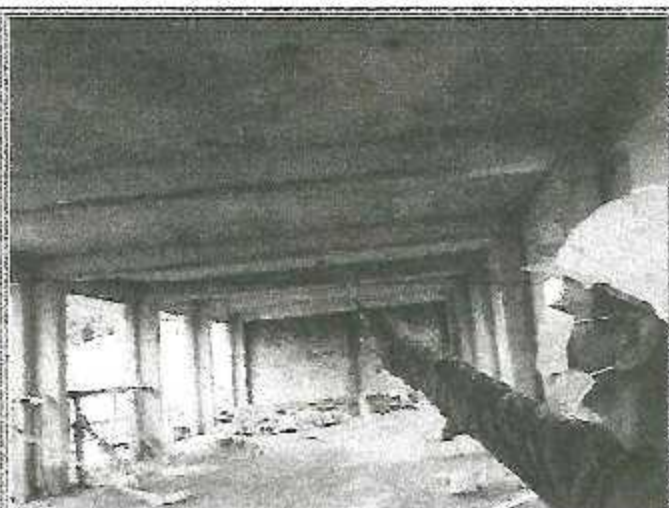
Vista: TARRAJEO COLUMNAS VIGAS Y CIFI ORRASO
