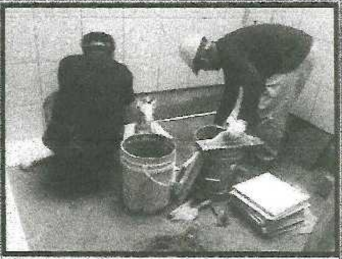
Vista: ENCHAPADA 2DO PISO SS.HH. MODULO D
