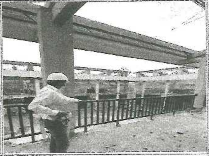
Vista: MONTAJE DE CORREAS METÁLICAS MÓDULO D,G,
