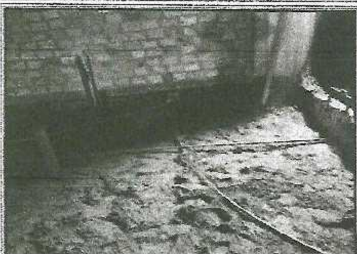
Vista: VACEO DE CONCRETO EN ZAPATAS DEL MÓDULO 0
