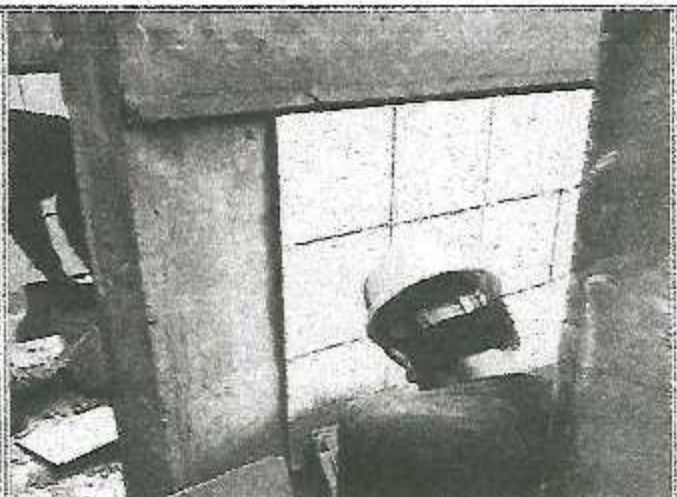
Vista; ENCHAPADA 2DO PISO SS.HH. MODULO D
