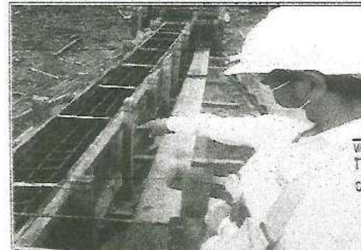
Vista: LIBERACIÓN PARA VACEAR CONCRETO EN TAPA DEL TANQUE ELEVADO
