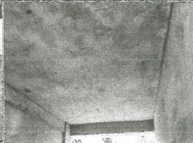
Vista; TARRAJEO DE CIELORRASO CON MEZCLA
