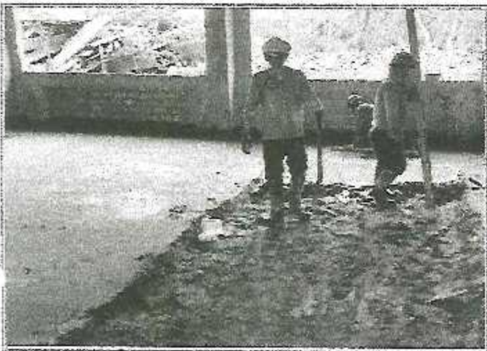
Vista: VACEO DE CONCRETO EN FALSO PISO
